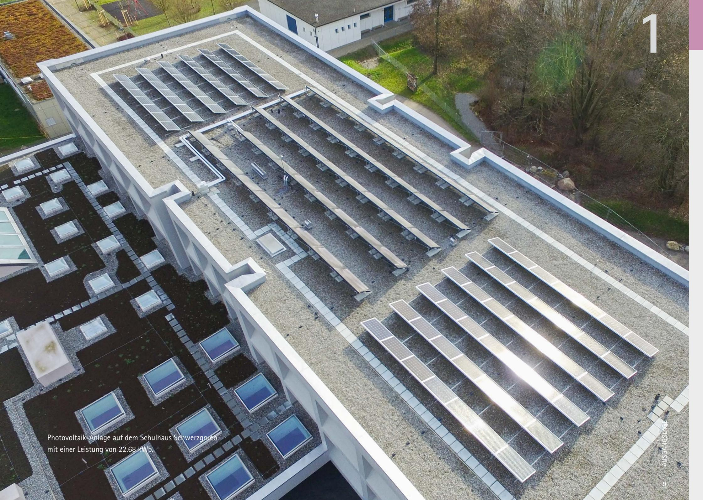
Photovoltaik-Anlage auf dem Schulhaus Schwerzgrueb mit einer Leistung von 22.68 kWp.
