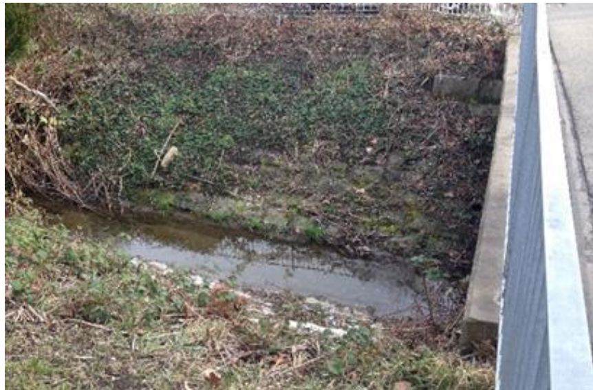
Abbildung 28 Uferböschung neben der Schwimmbadstrasse
