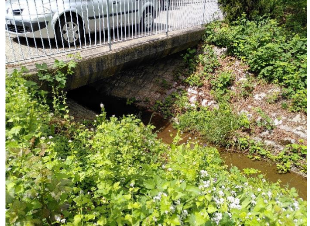
Kilometrierung 960, Brücke Schwimmbadstrasse
