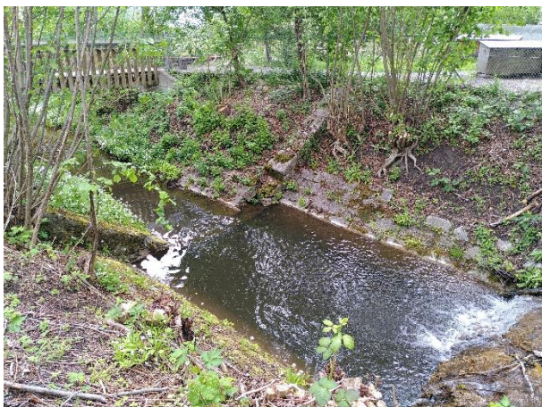
Kilometrierung 1030, Absturz / Becken
