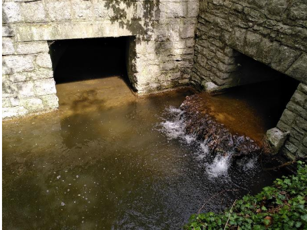
Kilometrierung 1130, Absturz / Becken
