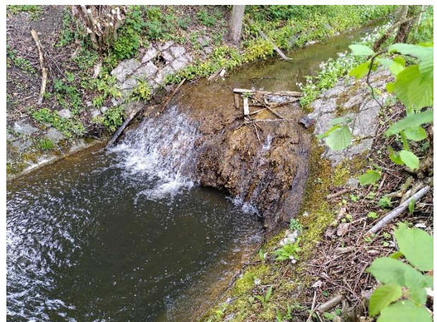
Kilometrierung 1030, Absturz / Becken
