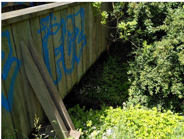
Kilometrierung 760, Brücke Uferweg
