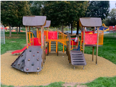
18 Fugenloser Fallschutz im Freibadspielplatz
