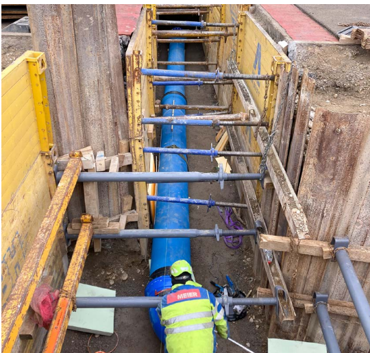
47 Umlegung Wassertransportleitung
