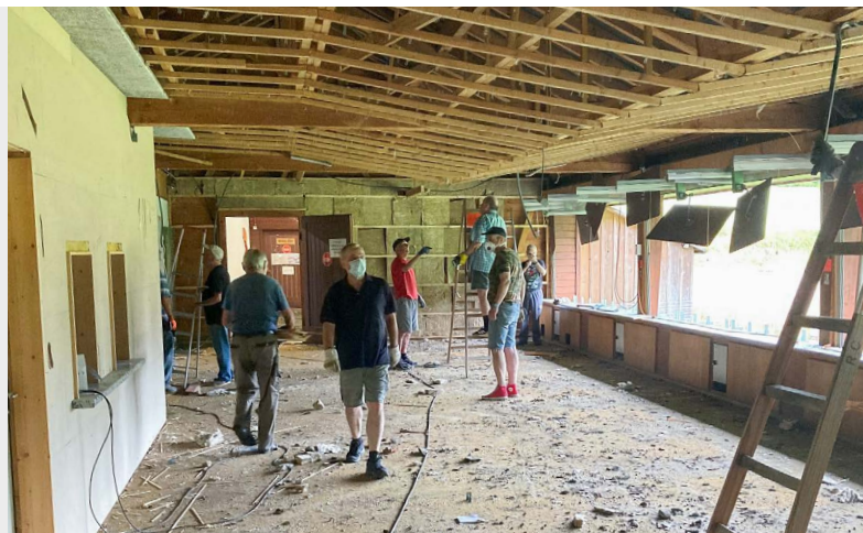
23 Die Pistolenschützen Bülach beim Rückbau
