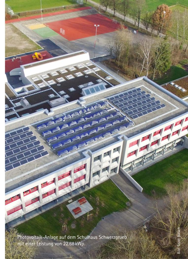
Photovoltaik-Anlage auf dem Schulhaus Schwerzgrueb mit einer Leistung von 22.68 kWp.
