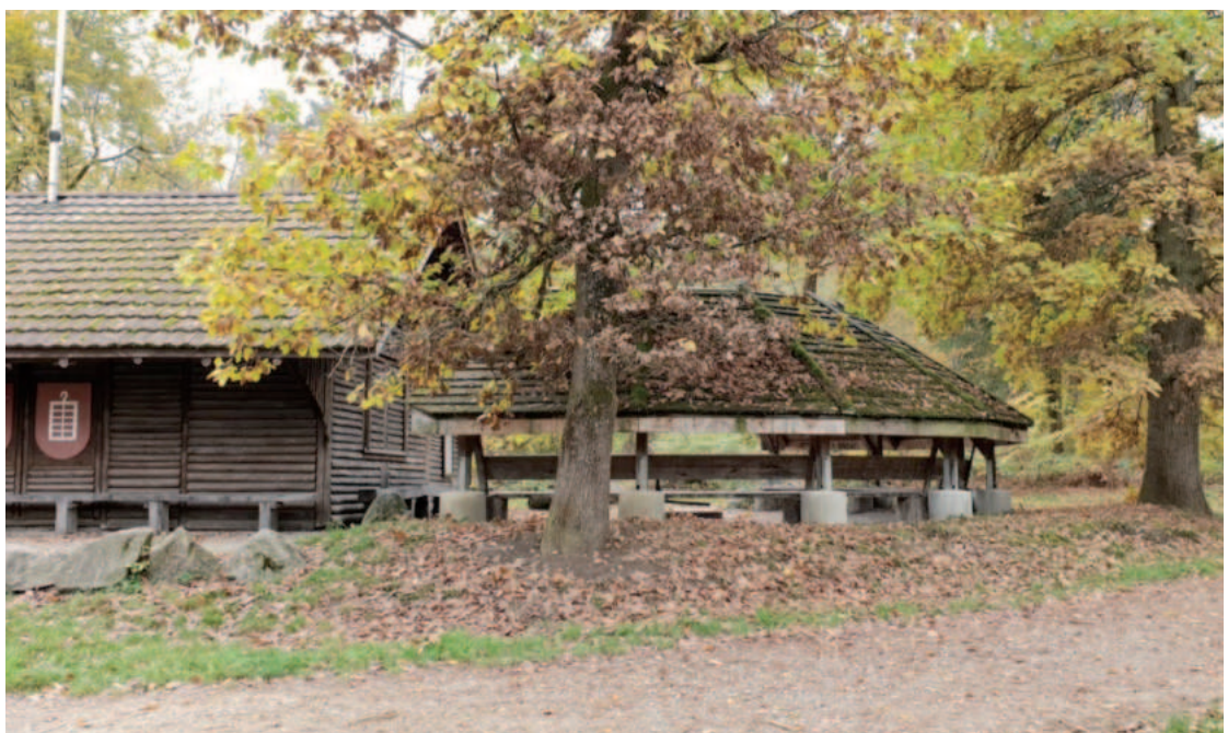
Abb.32: Waldhütte Höhragen (Foto: Enno Harms, Google Maps)
