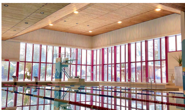
15 Die Sprungbucht wird neu mit sechs LED-Strahlern ausgeleuchtet
