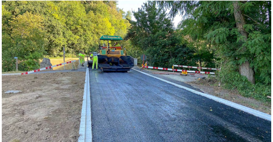
45 Sanierte Chellerhalsstrasse mit neuem Belag und Randabschlüssen
