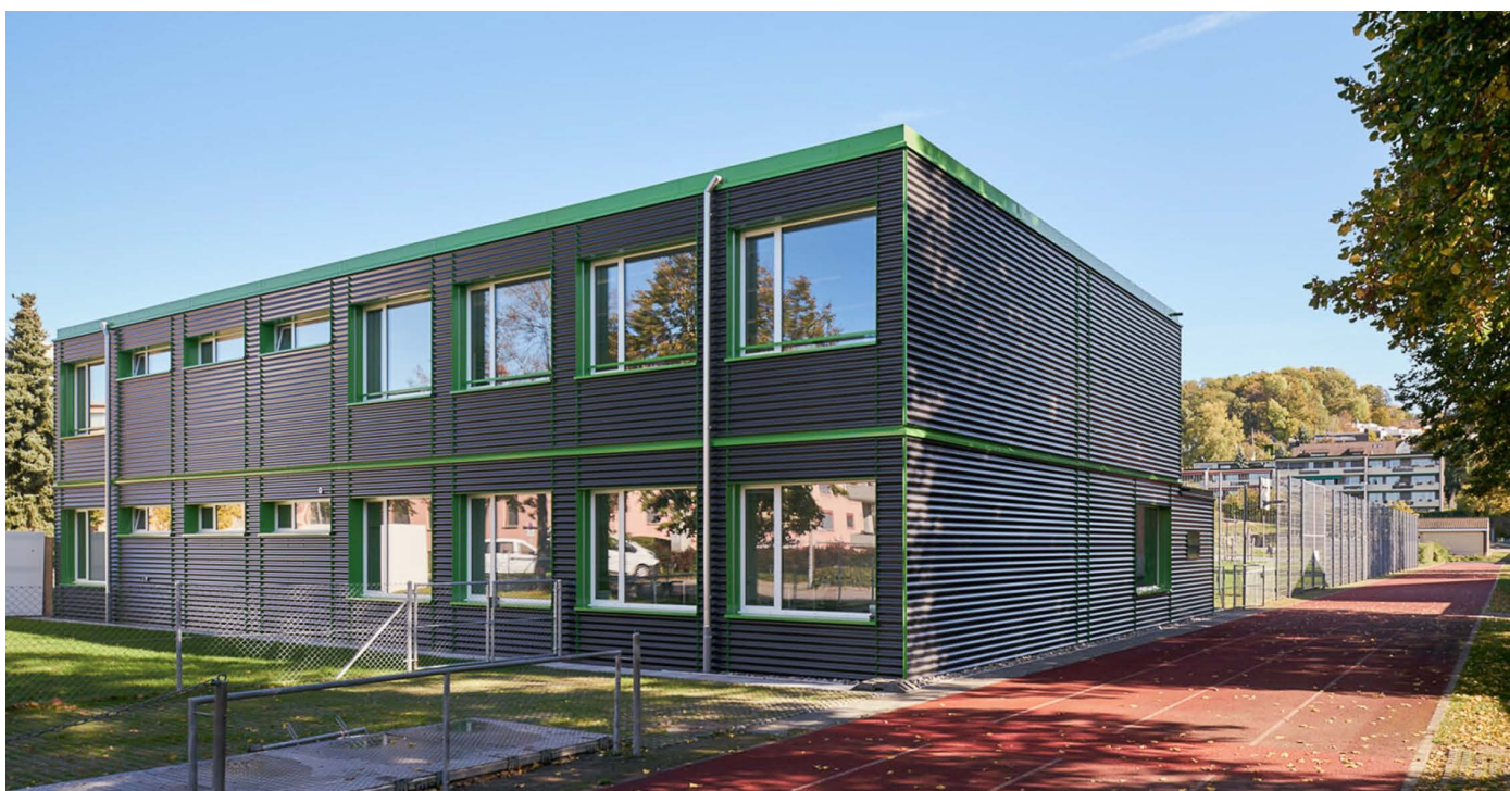
23 Modulbau Schulhaus Hohfuri
