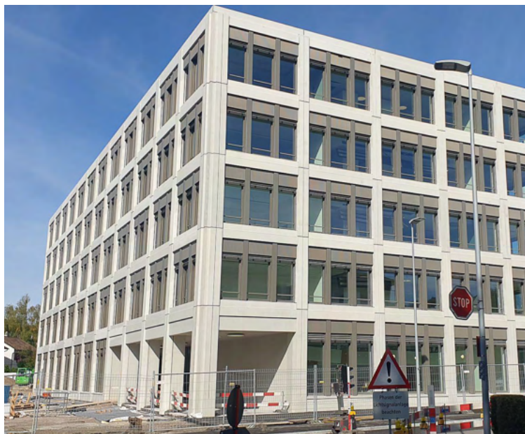
28 Das neue Stadthaus aussen
