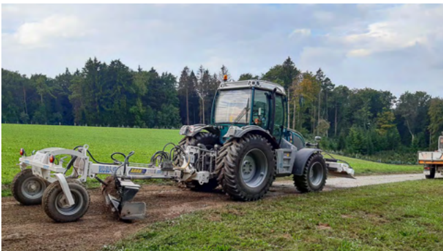
46 Leistungsfähige Geräte zur Instandstellung von Flurwegen und Waldstrassen: multifunktionaler Traktor mit Planierschild und Rüttelplatte
