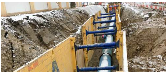
58 Umlegung Transportleitung beim Grundstück Nr. 2763
