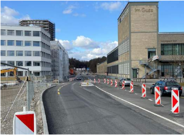
54 Ausbau Kreuzung Schaffhauser-/Glashüttenstrasse und Ersatz Wasserleitung
