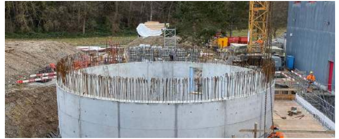
56 Bauarbeiten des Stapelbehälters in der ARA
