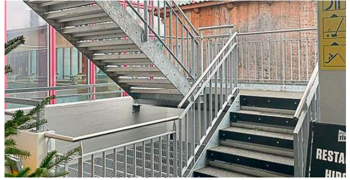
17 Neue Treppe mit Zwischenpodest
