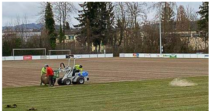
15 Der Rollrasen auf dem Fussballplatz wird verlegt
