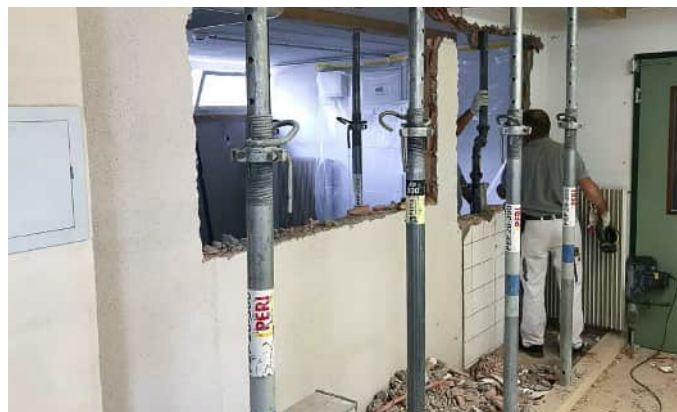
22 Die neue Einsatzzentrale im Rohbau
