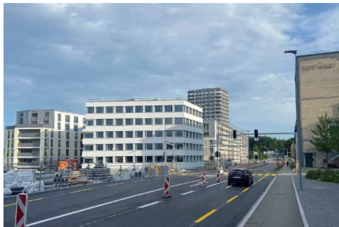
67 Kreuzung Schaffhauser-/Glashüttenstrasse; Inbetriebnahme Lichtsignalanlage
