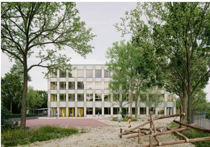
45 Schulhaus Guss Visualisierung Hauptfassade mit Pausenplatz
