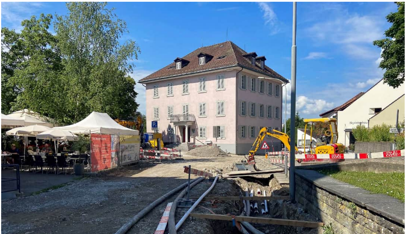
66 Begegnungszone Altstadt 4. Etappe, Hans-Haller-Gasse, Werkleitungsarbeiten
