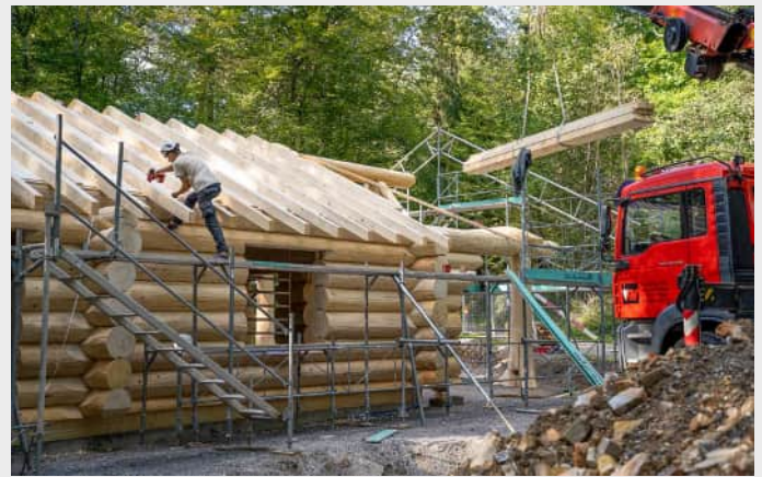
46 Aufrichten der neuen Spitalwaldhütte
